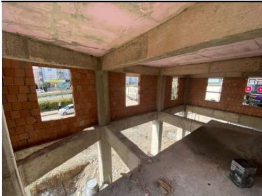
Şekil 2.2.3 Sonradan Yapılan Asma kat İmalatı
