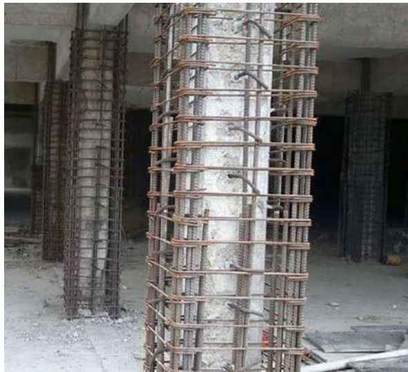
Şekil 2.1.2 Epoksi Enjeksiyon Uygulaması Kolon Mantolama İşlemi
