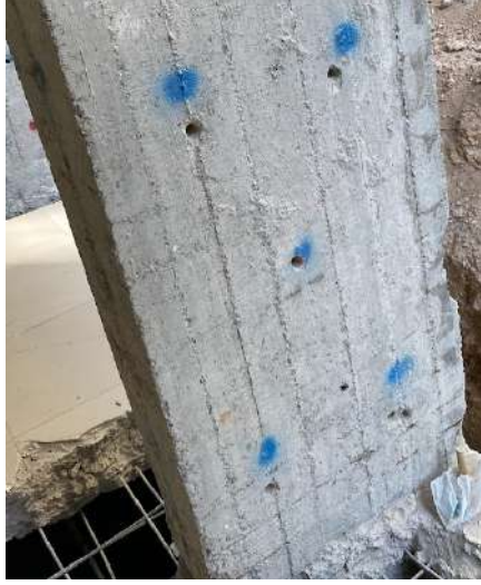
Şekil 4.9.5 Kolon, kiriş ve döşemede projeye uygun çap ve aralıklarda ankraj deliklerinin matkap (hilti) ile açılması işlemi
