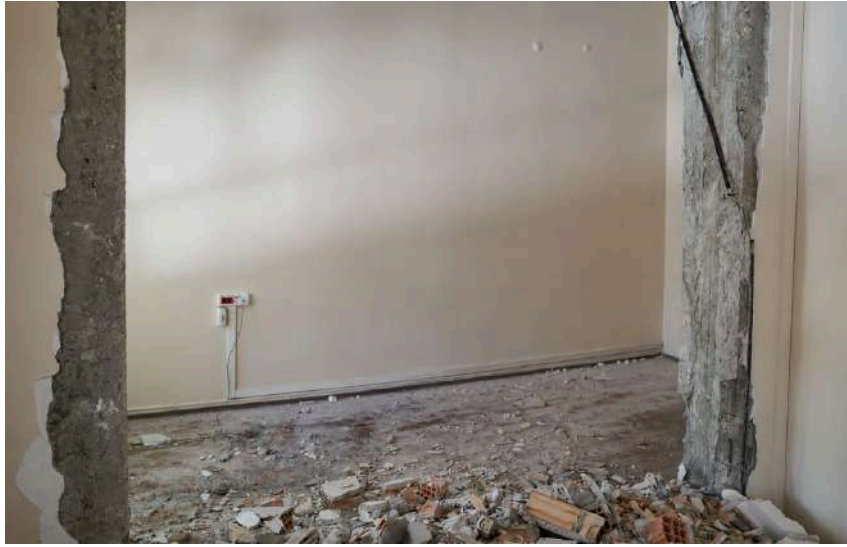
Şekil 4.9.2 Perde yapılacak yerdeki dolgu duvarın yıkılması
