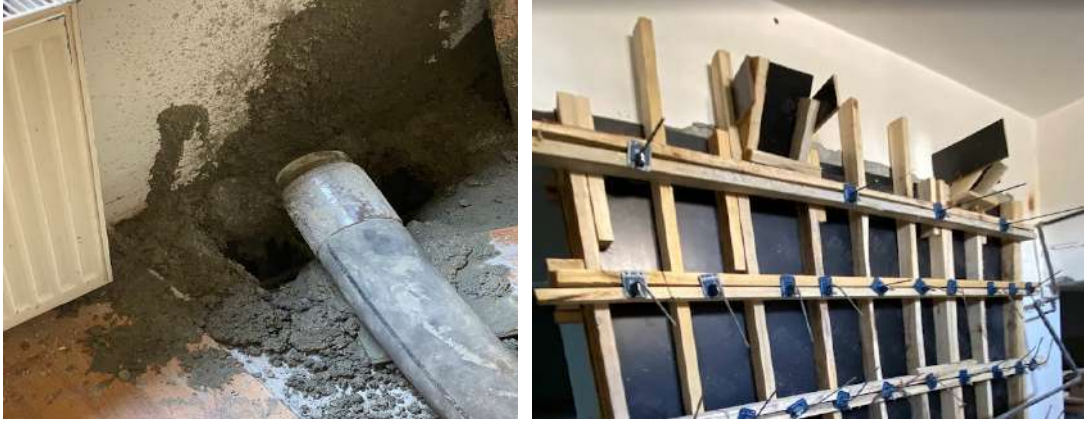
Şekil 4.9.13 Üst döşemede bırakılan boşluktan betonun aktarılması ve donatısı tamamlanan perde kalıbının en üstüne huni şekli verip beton dökülmesi işlemi.
