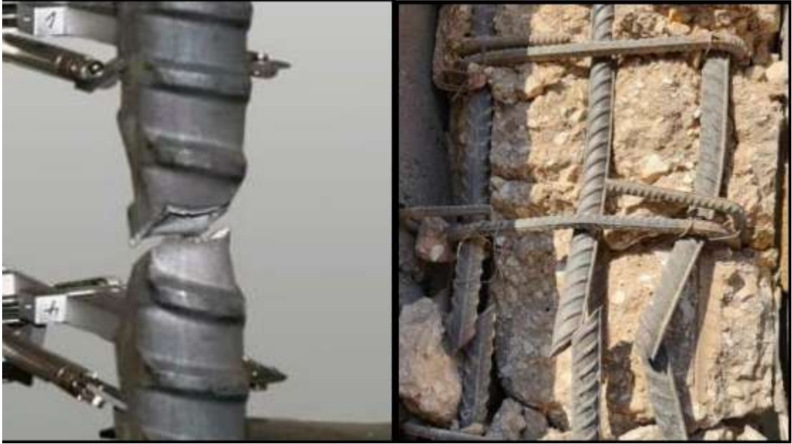
Şekil 2.2.2 standartlara uygun olmayan malzemedeki gevrek kırılma.
