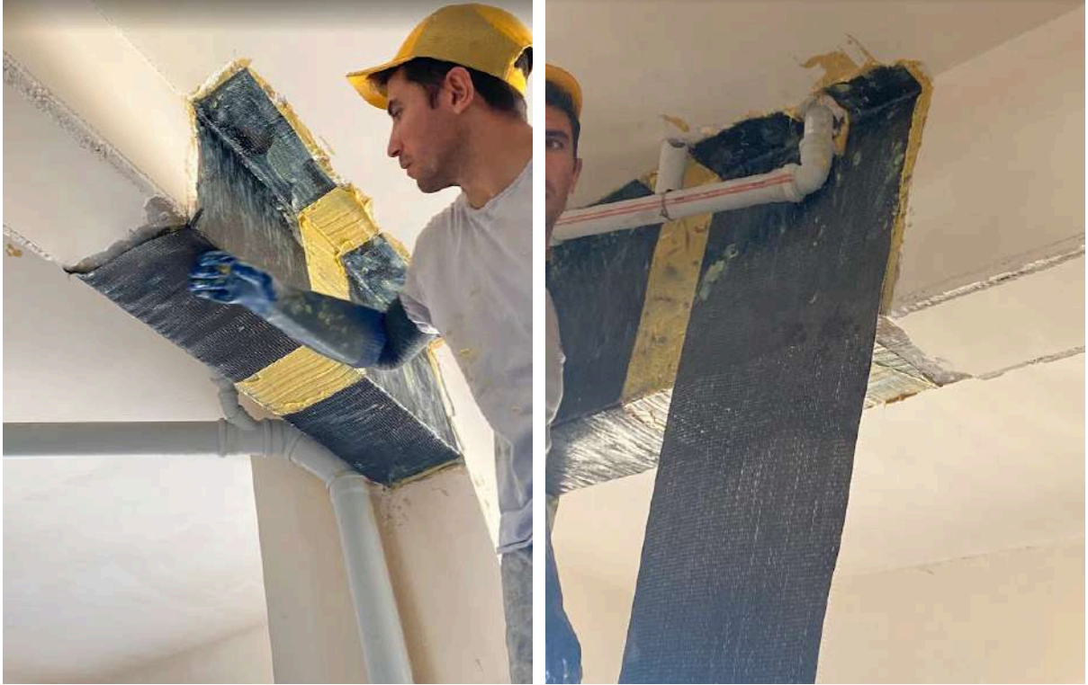
Şekil 4.9.20 İki kat Reçine uygulama görseli
