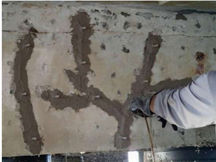
Şekil 2.1.1 Epoksi Enjeksiyon Uygulaması
