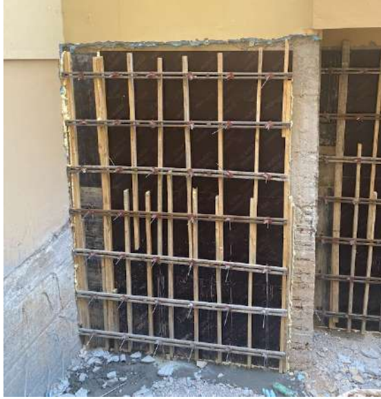
Şekil 4.9.11 Kalıbı Kapatılan Perde Elemanı
