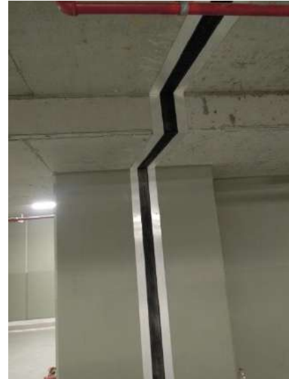
Dilatasyon Boşluğunun gizlenmesi
