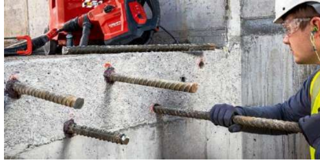
řekil 4.9.8 Epoksi uygulamasından sonra rotların dndrlrek deliklere yerleřtirilmesi
