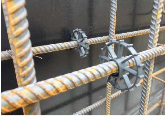
Şekil 4.9.12 Paspayı aparatı ve plywood kalıbı tutan tij demirleri ve çiroz elemanı
