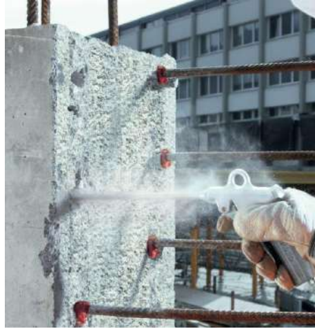
Şekil 4.9.6 Açılan ankraj deliklerinin içindeki toz ve parçacıkların, kimyasal ankraj öncesi basınçlı hava ile tamamen uzaklaştırılması işlemi
