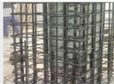
Betonarme Mantolama
