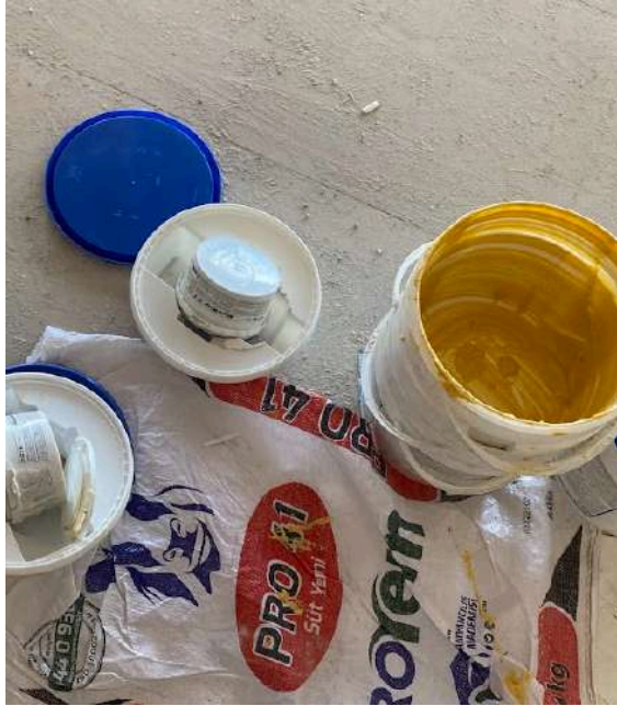
Şekil 4.9.18 Epoksi Reçine Çift bileşenli olarak kutusu içerisinde karıştırılarak yüzeye sürülmeye hazır hale getirilir
