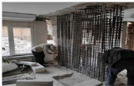
Betonarme Perde Ekleme
