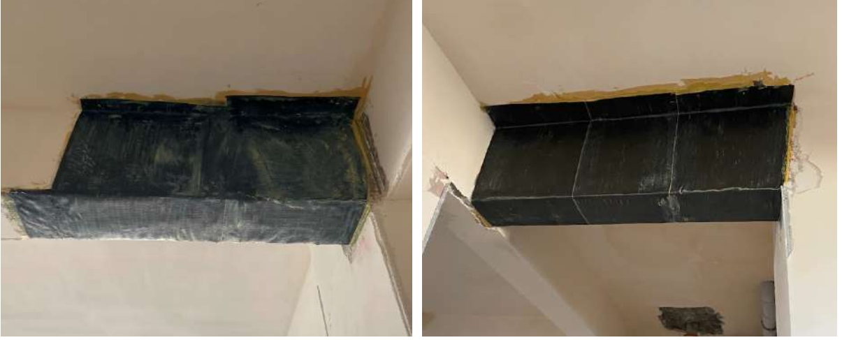
Şekil 4.9.21 FRP sargı ile sarılması
