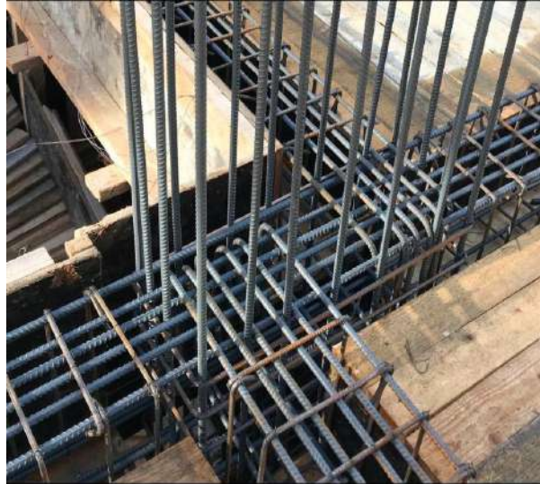
Şekil 2.8.5 Kolon Kiriş Düğüm Noktası
