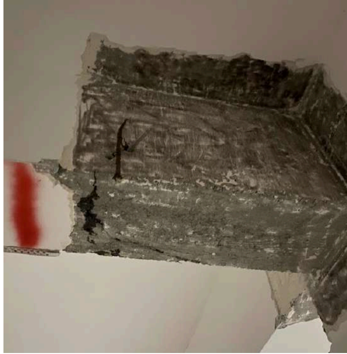
Şekil 4.9.16 Sargı öncesi beton yüzeye incek kadar temizlenerek işleme başlanır
