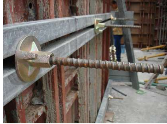
Şekil 4.9.12 Paspayı aparatı ve plywood kalıbı tutan tij demirleri ve çiroz elemanı
