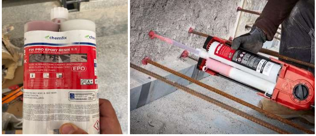
řekil 4.9.7 yapısal epoksinin tabancayla enjekte edilmesi iřlemi
