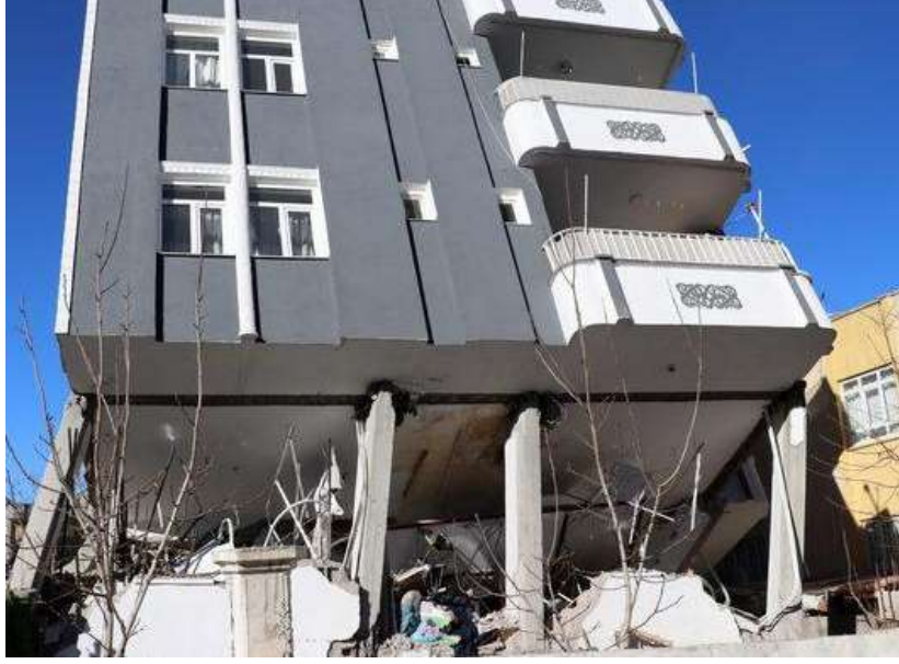
Şekil 2.8.8 Yumuşak Kat Etkisinde Hasar alan bir bina
