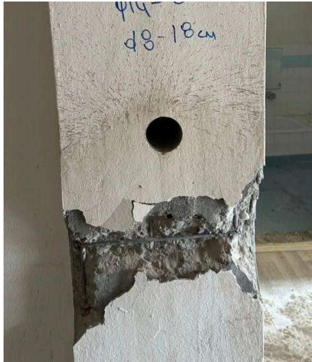
Şekil 2.7.2 Taşıyıcı Elemandan Karot Alınması
