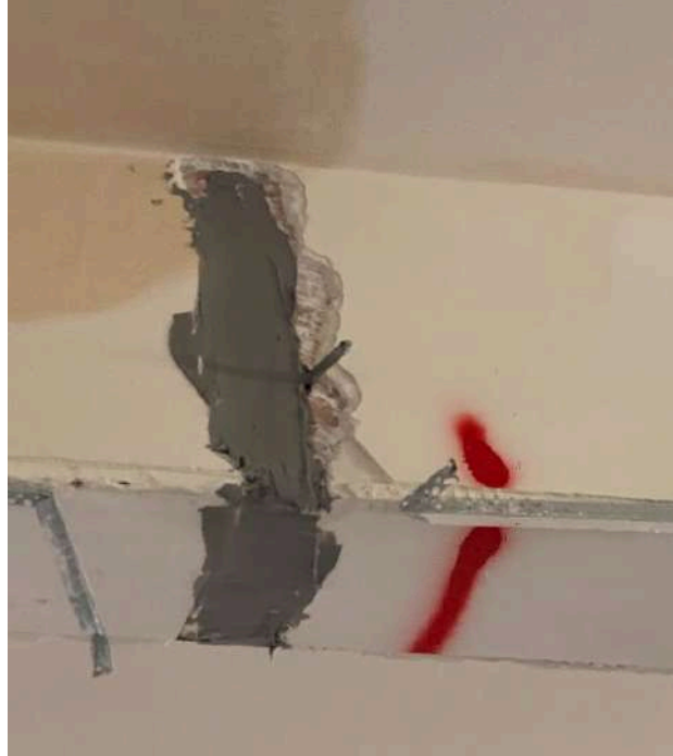
Şekil 4.9.17 Hasar alan kirişlere epoksi enjeksiyon yapılarak çatlakların doldurulması ve tamir harcı ile yüzeyin sıvanması
