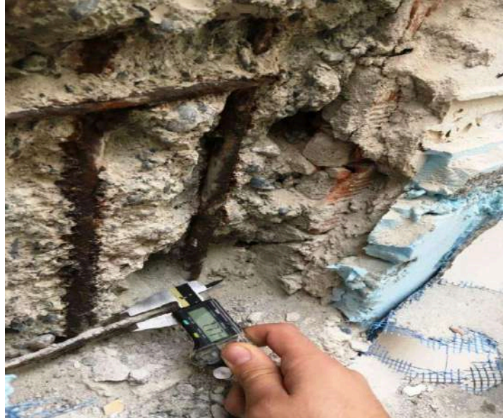
Şekil 2.4.4 Bir kolonda paspayı tabakasının lokal olarak kırılarak etriye aralığı, kanca açısı (135 derece) ve donatı çapının kumpasla ölçülmesini gösteren Sıyırma İşlemi .
