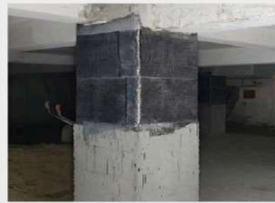
CFRP (Karbon Elyaf) Sargı
