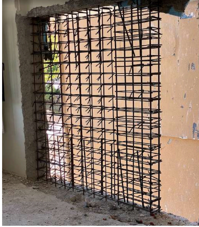
Şekil 4.9.10 Perde donatısı (karkas) imalatı tamamlanmış kalıp aşamasına geçmiş bir taşıyıcı
