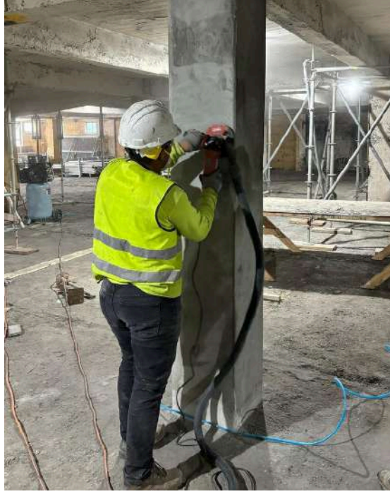
Şekil 4.9.3 Mevcut kolon, kiriş ve döşeme yüzeylerindeki sıva, boya ve kaplamaların kazınarak çıplak betonun ortaya çıkarılması işlemi
