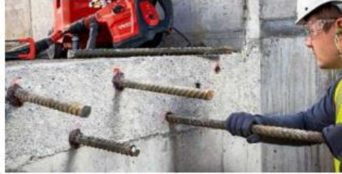
Şekil 4.9.8 Epoksi uygulamasından sonra rotların döndürülerek deliklere yerleştirilmesi
