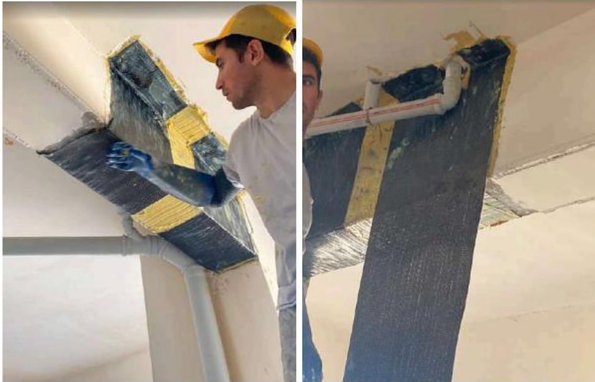
Şekil 4.9.20 İki kat Reçine uygulama görseli
