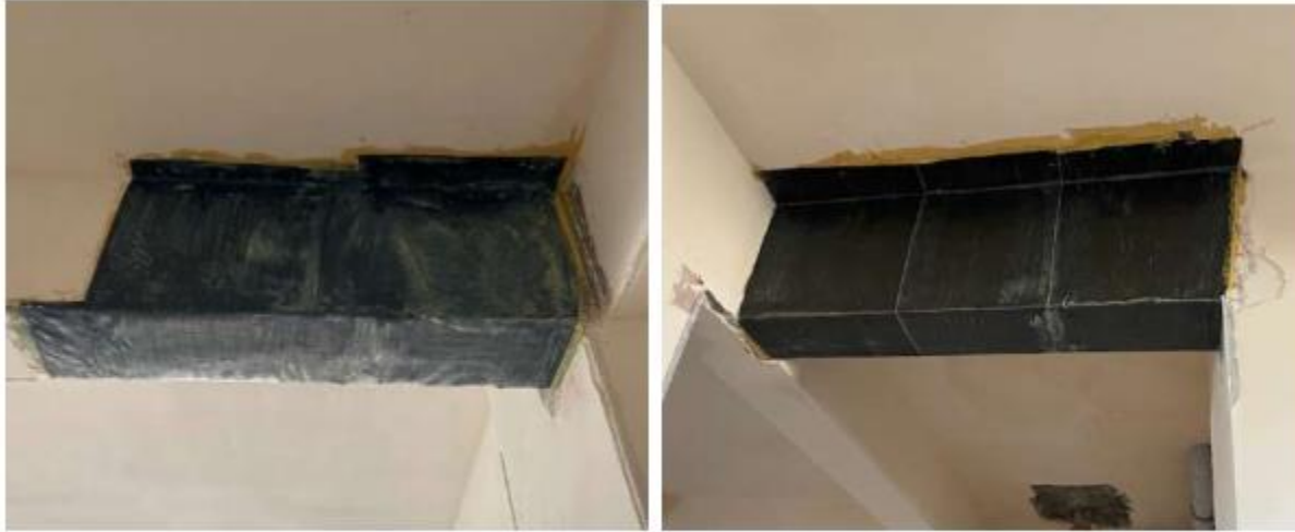
Şekil 4.9.21 FRP sargı ile sarılması
