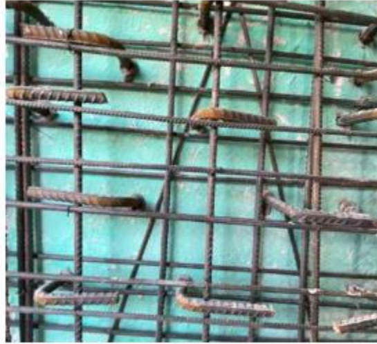
Şekil 4.9.4 Eski beton yüzeyine yeni dökülecek olan betonla aderansı artırmak amacıyla aderans artırıcı astarının uygulanması işlemi
