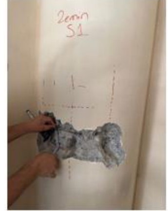
Şekil 4. Donatı tespit işlemleri
