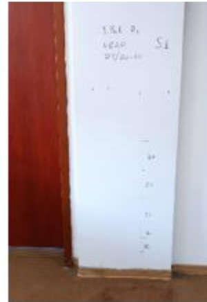
Şekil 4. Donatı tespit işlemleri
