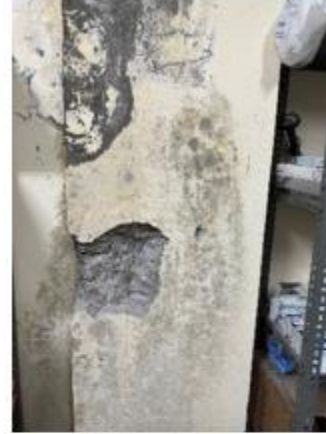
Şekil 4. Donatı tespit işlemleri
