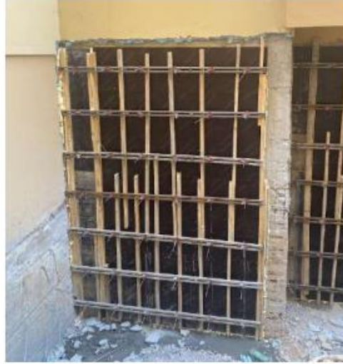
Şekil 4.9.11 Kalıbı Kapatılan Perde Elemanı
