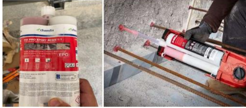
Şekil 4.9.7 yapısal epoksinin tabancayla enjekte edilmesi işlemi
