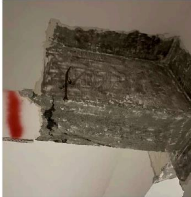
Şekil 4.9.16 Sargı öncesi beton yüzeye incek kadar temizlenerek işleme başlanır
