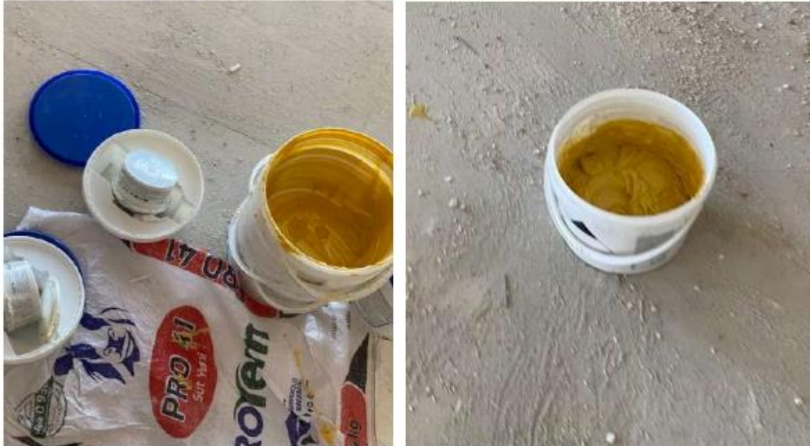
Şekil 4.9.18 Epoksi Reçine Çift bileşenli olarak kutusu içerisinde karıştırılarak yüzeye sürülmeye hazır hale getirilir
