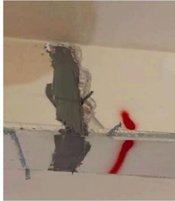
Şekil 4.9.17 Hasar alan kirişlere epoksi enjeksiyon yapılarak çatlakların doldurulması ve tamir harcı ile yüzeyin sıvanması
