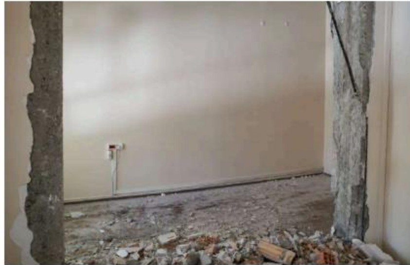
Şekil 4.9.2 Perde yapılacak yerdeki dolgu duvarın yıkılması
