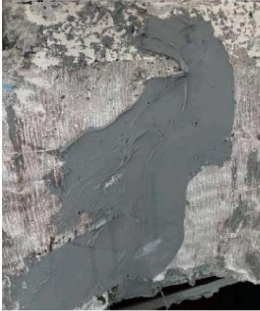
Şekil 4.9.17 Hasar alan kirişlere epoksi enjeksiyon yapılarak çatlakların doldurulması ve tamir harcı ile yüzeyin sıvanması
